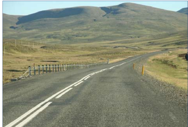
Mynd 11 744 Þverárfjallsvegur, kafli 03 Laxárdalsheiði, byggður að hluta á gömlum vegi, breikkun
