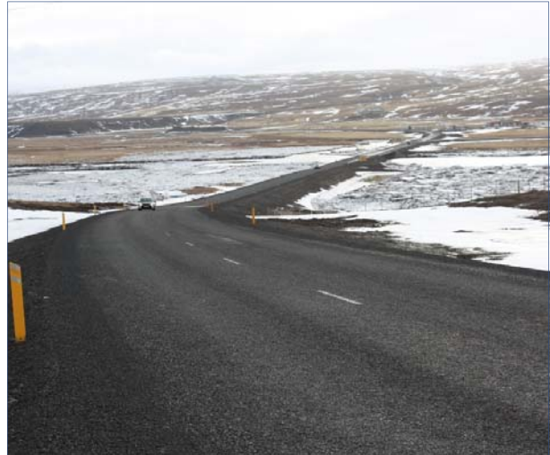
Mynd 9 Hringvegur í Hrútafirði, nýbygging 2009
