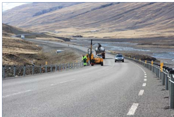
Mynd 31 Hringvegur 1 í Norðurárdal Skagafirði, framkvæmdir við víravegrið
