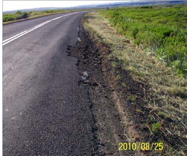
Mynd 13 Slæmt ástand á klæðingu - þarfnast endurbóta
